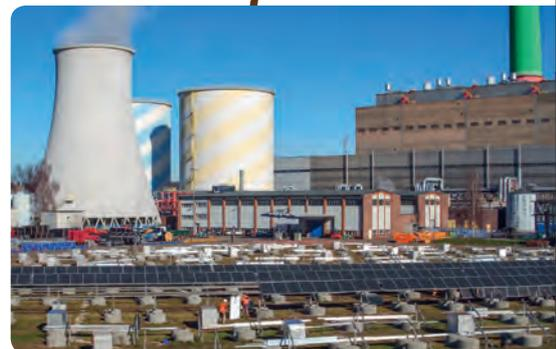
5.000 Module bestehend aus je 60 polykristallinen Solarzellen sind für das neue Motorenheizkraftwerk umgezogen.
